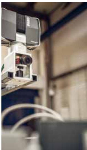
Kameras überwachen die Rückbauarbeiten
