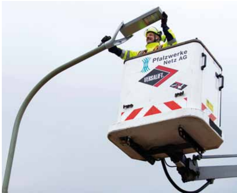
Mitarbeiter der Pfalzwerke Netz AG haben die Leuchtmodule von 25 Straßenlaternen im pfälzischen Maxdorf für den Feldtest gewechselt. Sparsame Mid-Power-LEDs sorgen nun für bessere Ausleuchtung im Musikerviertel
