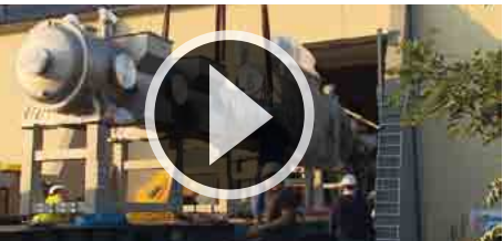
Ankunft des 25 Tonnen schweren und 16 Meter langen Kryostat- und Magnet-systems für die Tritiumquelle
